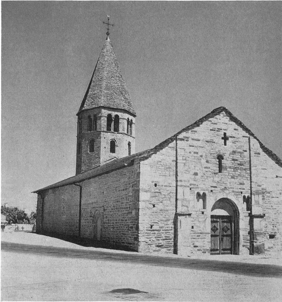
Kirche Saint-Pierre-de-Clages. Ansicht von Westen mit oktagonalem Turm, 1153 erstmals genannt
