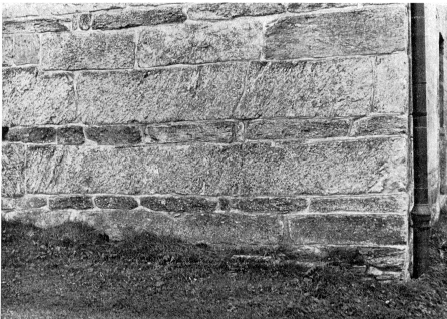
Mauerpartie an der NW-Ecke des Schiffes, mit dem Wechsel von breiten und schmalen Steinen. Der untere breite Quader ist 3,7 m lang. Fast alle Steine sind Cipolline (Ausnahme: der dunklere große Quader rechts oben besteht aus einer andern Marmorart)
