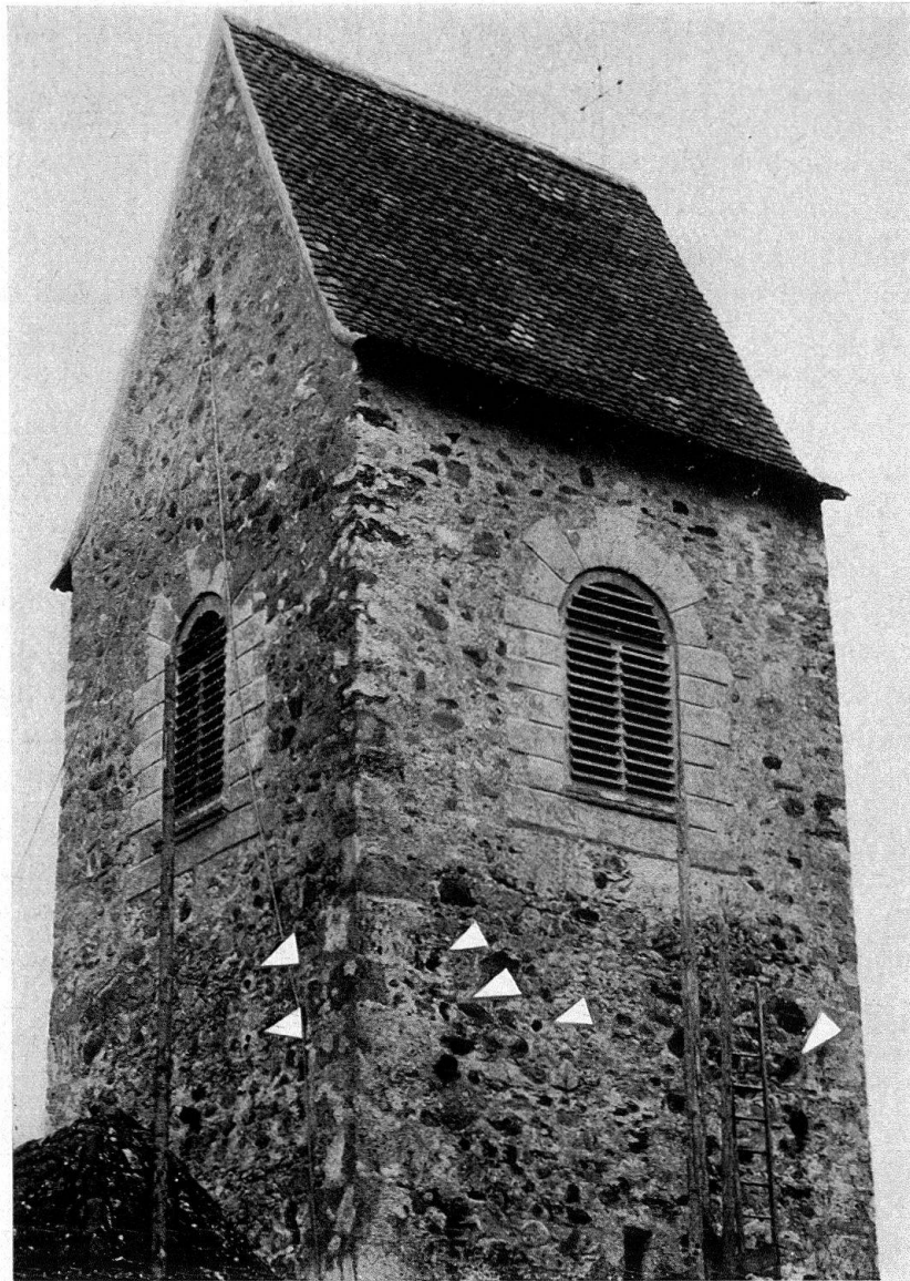
Magdenau, St. Verena. Oberer Teil des unter Erhaltung der Patina und des Flechtenbewuchses fertig restaurierten Turmes. Die weißen Pfeile weisen auf eine Anzahl von Nisthöhlen hin
