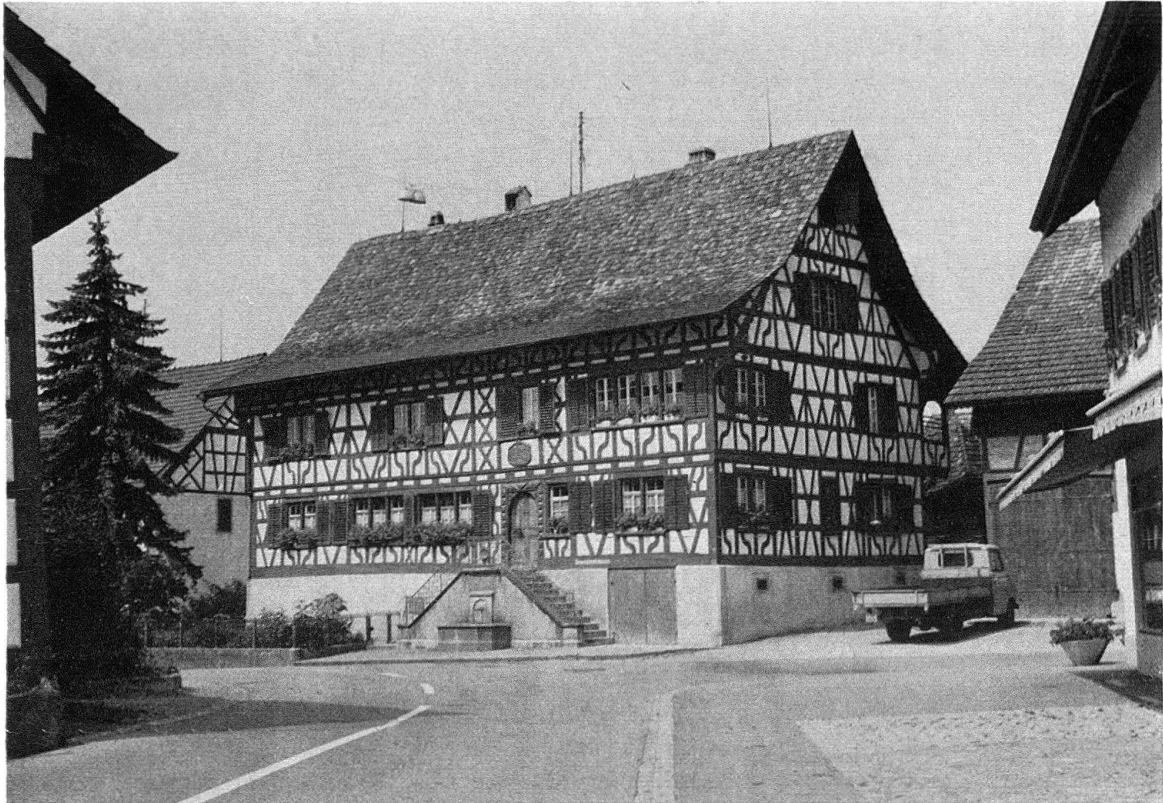
Abb. 5. Reiches Fachwerk, stockwerkweise abgebunden, liegender Stuhl. Marthalen ZH, 1715
