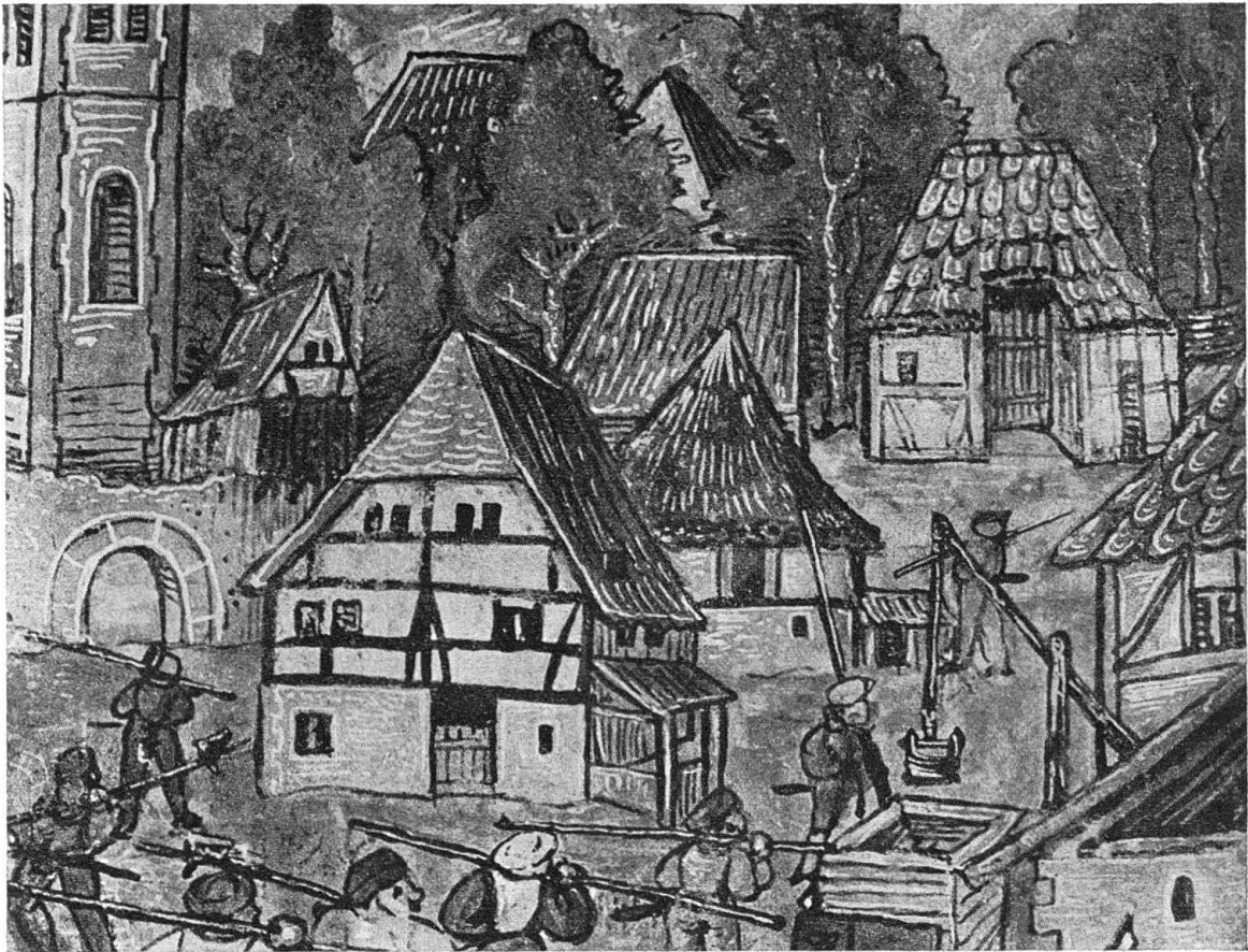
Abb. 8. Alte Darstellung nordostschweizerischen Fachwerkes, durchgehende Ständer, große Gefache, Langstreben. D. Schilling, Luzerner Bilderchronik 1513, Fol. 151 b
