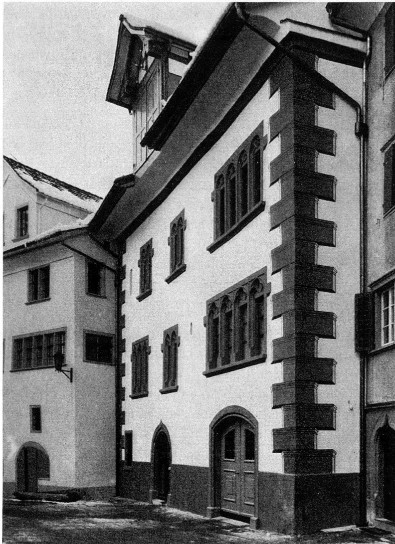
Abb. 2. Lichtensteig. Altes Rathaus, nach der Restaurierung von 1968
