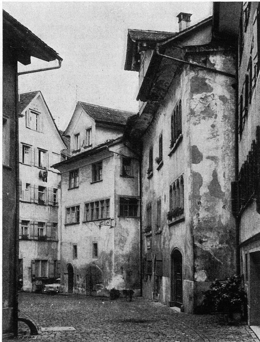
Abb. 1. Lichtensteig. Altes Rathaus, Zustand vor der Restaurierung
