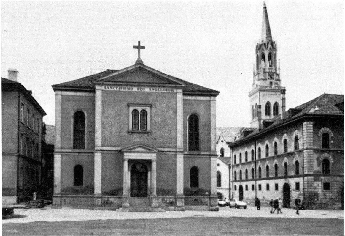
St. Gallen, Schutzengelkapelle. Der «Tempel Gottes» bildet zusammen mit den ebenfalls durch Felix Kubli erbauten Nachbargebäuden die Nordwand des Domplatzes. Dahinter die St. Laurenzenkirche, welche um die Mitte des 19. Jhs. durch Johann Georg Müller und Ferdinand Stadler das neugotische Gewand erhielt
