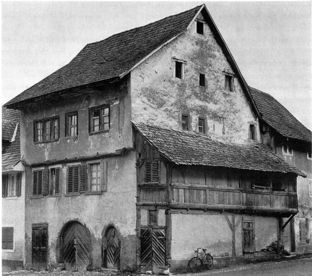
Abb. 1. Zurzach, Haus «zum Elefanten», Ansicht von Südwesten, 1966.
