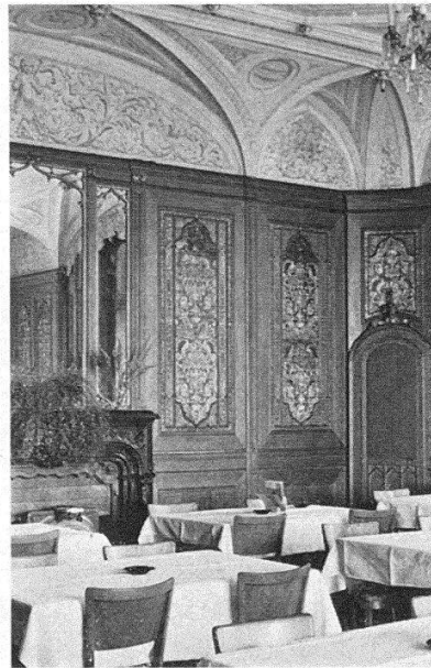
Abb. 5. Schloß Schadau. Nordostecke im Gartensaal des Erdgeschosses
