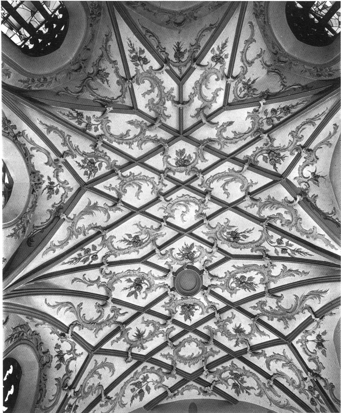
Herisau, Reformierte Kirche. Spätgotisches Netzgewölbe im Chor, Werk des Konstanzer Münsterbaumeisters Lorenz Reder, 1516–1520: die grau- und ockertonig durchfärbten Stukkaturen wurden 1782 von Andreas Moosbrugger zugefügt (Eine Farbabbildung dieses stuckierten Gewölbes bringt das Buch von Andreas Morel «Andreas und Peter Anton Moosbrugger», das als zweite Jahressgabe erscheint)
