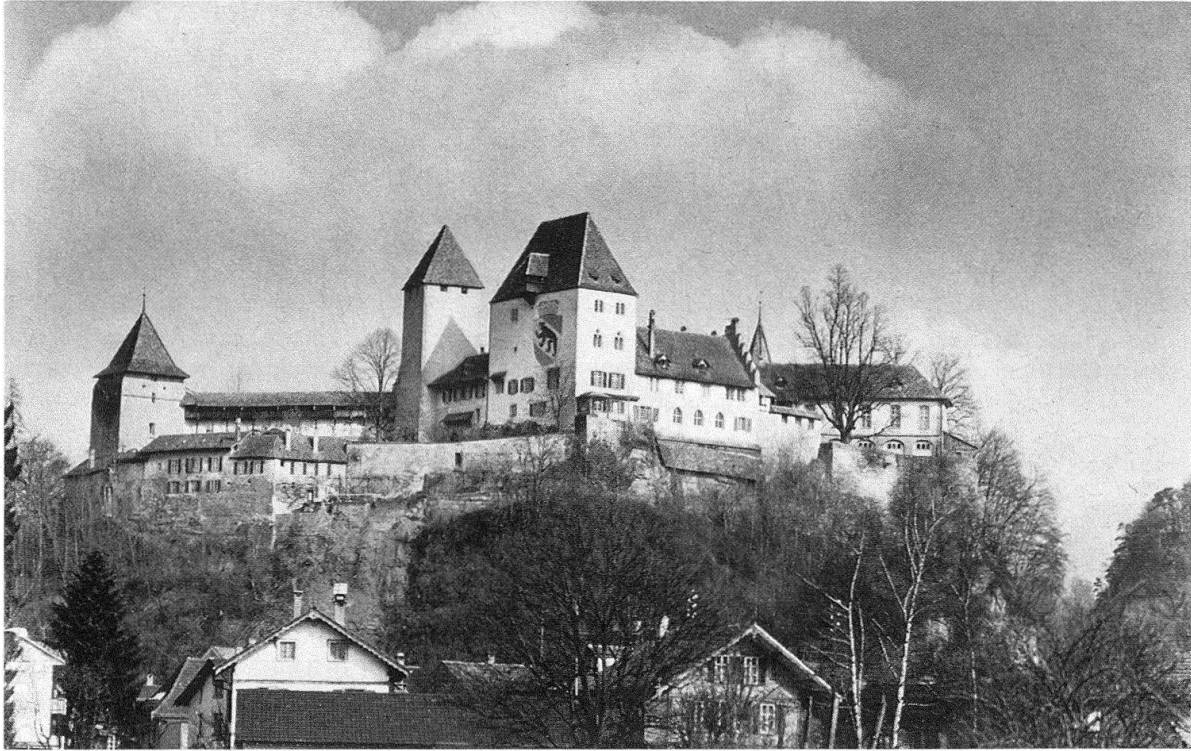
Schloss Burgdorf von Süden, 1965. Von links nach rechts Torturm, Bergfried, Donjon, Halle unter Satteldach (Fenster 16./20. Jahrhundert), Kornhaus (1751)
