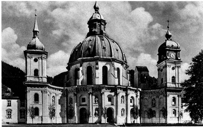
Abb. 7. Kloster- und Wallfahrtskirche Ettal, mit der 1711 von Zuccalli begonnenen Fassade
