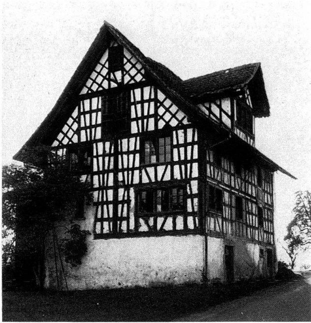
Schönenberg, Hinteregg, Bauernhaus Hitz (Ostansicht) nach der Restaurierung
