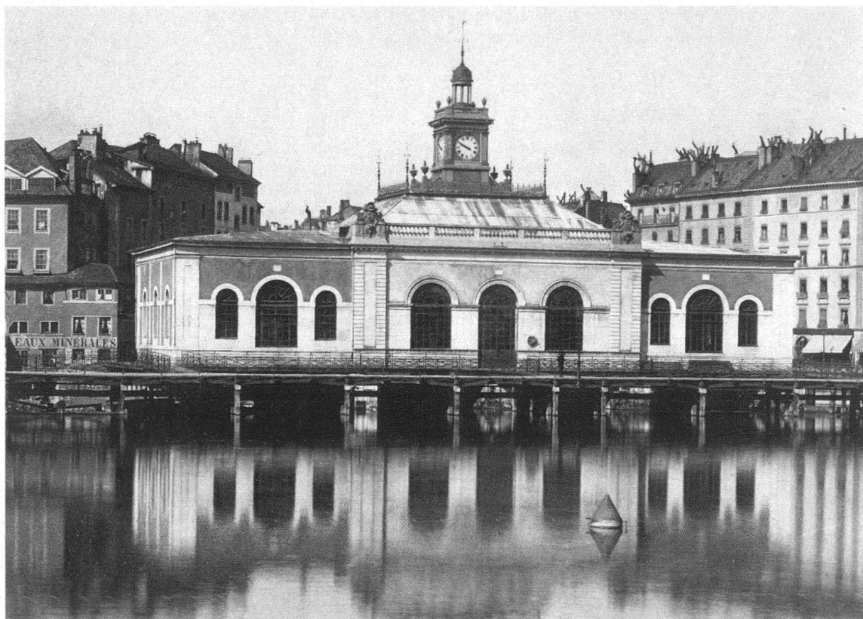
Usine hydraulique du pont de la Machine, achevée en 1872. Etat antérieur à la «restauration purificatrice» fonctionnaliste (Document Musée du Vieux-Genève)
