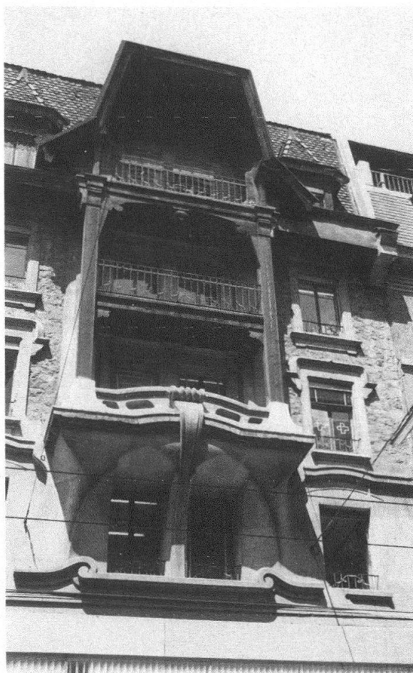
Fig. 3. Balcon bulbeux en béton et «dôme» en charpente, rue du Marché («Pharmacie principale»), 1903/1904
