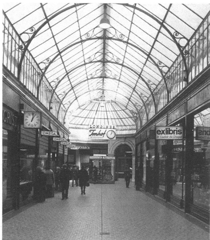
Fig. 5. Galerie vitrée de 1906. Transversale (Passage des Lions/Confédération)
