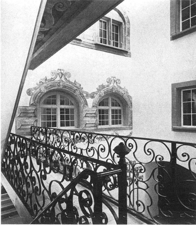
Zürich, «Unteres Rech», Neumarkt 4. Restaurierte Fassadenmalerei in Grisaille- Technik, 16. Jh.
