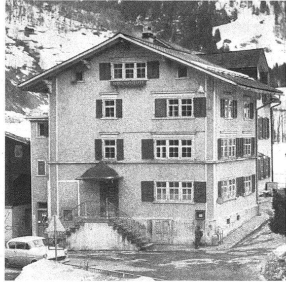
Elm. 1894 gab man dem Pfarrhaus das Aussehen eines einfachen, gemauerten Wohnhauses, indem man es verputzte und Fensterverdachungen und Klappläden anbrachte. Wie steif und gewöhnlich sah es doch aus!
