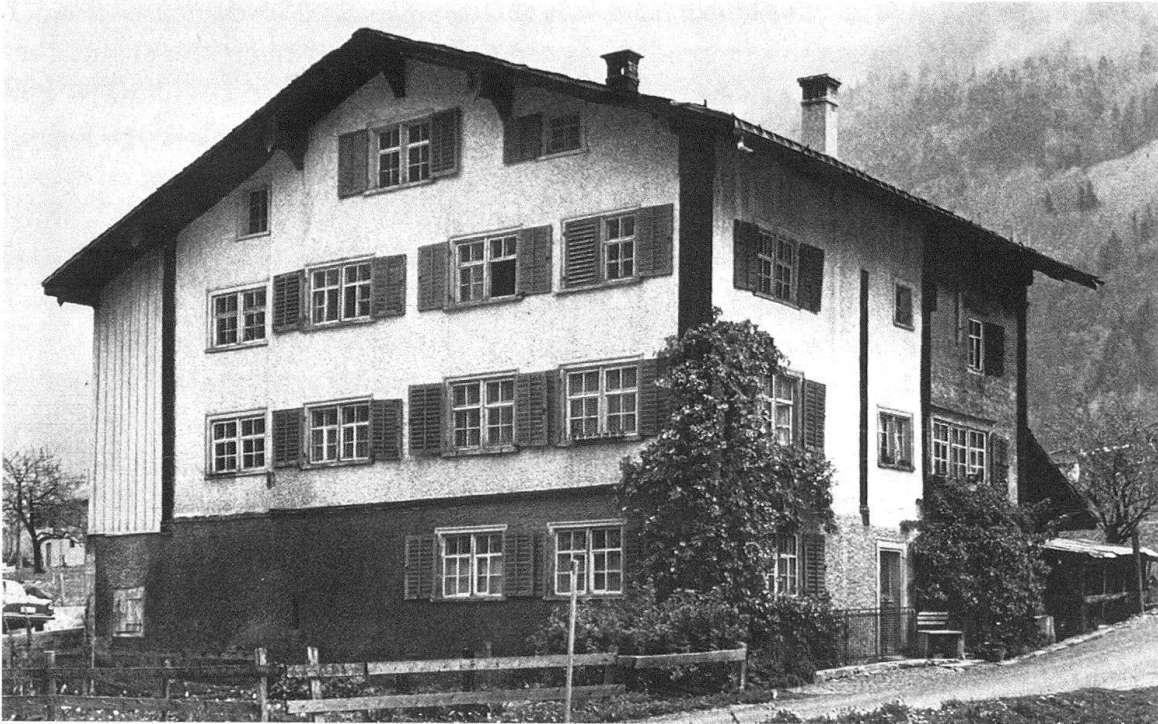
Linthal. Schiesser-Haus. Vor der Restaurierung war es eines jener zahllosen glarnerischen Holzhäuser, die im 19. und 20. Jh. durch Verputz und grosse Einzelfenster das Aussehen gleichgültiger Mietshäuser erhalten hatten
