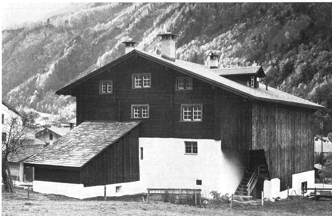
Linthal. Schiesser-Haus. Bei der Restaurierung vergrößerte man einzelne Fenster der Ostseite und die Dachgaube. Laube und Stall bekamen eine neue, senkrechte Brettverschalung. Das Dach deckte man mit Eternitschiefer ein, den Stall mit altem Schiefer
