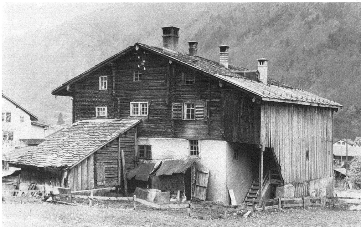
Linthal. Schiesser-Haus. Vor der Restaurierung war der Kantholzblock an der Ostseite und hinter der Laube noch sichtbar. Die Dächer der Stallscheune und des Hauses waren mit Schiefer eingedeckt, über der Laube mit Blech
