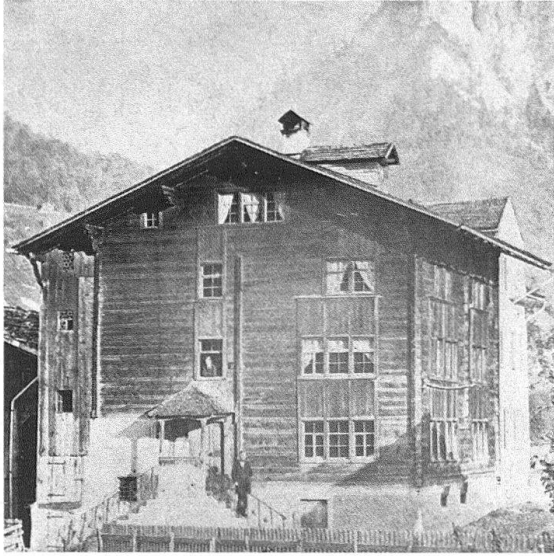
Elm. Das Pfarrhaus von 1807/08 im ursprünglichen Zustand, ein stattlicher Blockbau mit unverzierten Falläden. Die dokumentarische Photo aus der Zeit um 1880 war für die Aussenrestaurierung wegleitend
