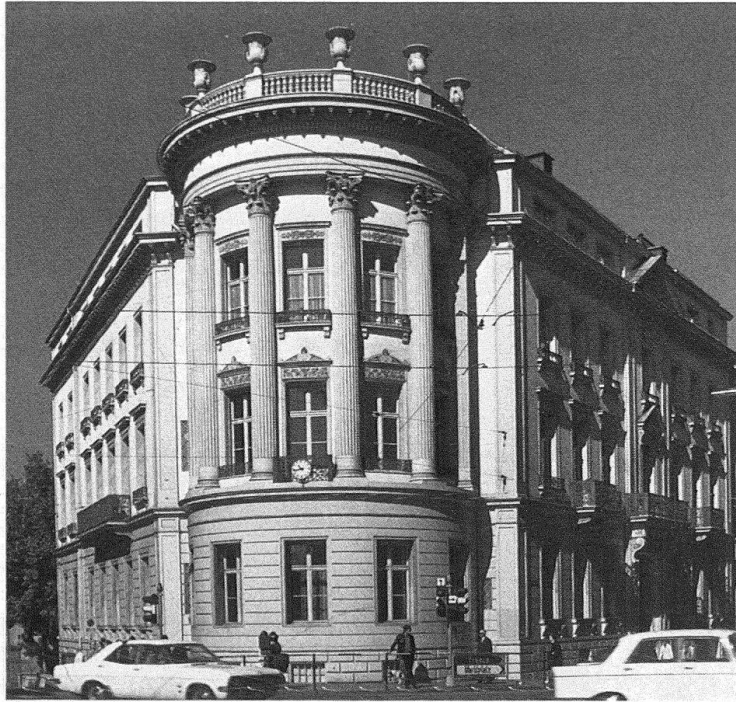
Schilthof, Freie Strasse/ Steinenberg, 1841–1842 als Wohnhaus nach angeblich französischen Plänen von Johann Jakob Stehlin d. Ä. (1803–1879) gebaut; 1899–1900 von Fritz Stehlin (1861–1923) erweitert. Erstes Basler Beispiel eines Eckrundbaues als Gelenk zwischen spitzwinklig zusammenstossenden Flügeln, hier mit Anklängen an die Monopterostempel in Gärten des 18. Jahrhunderts
