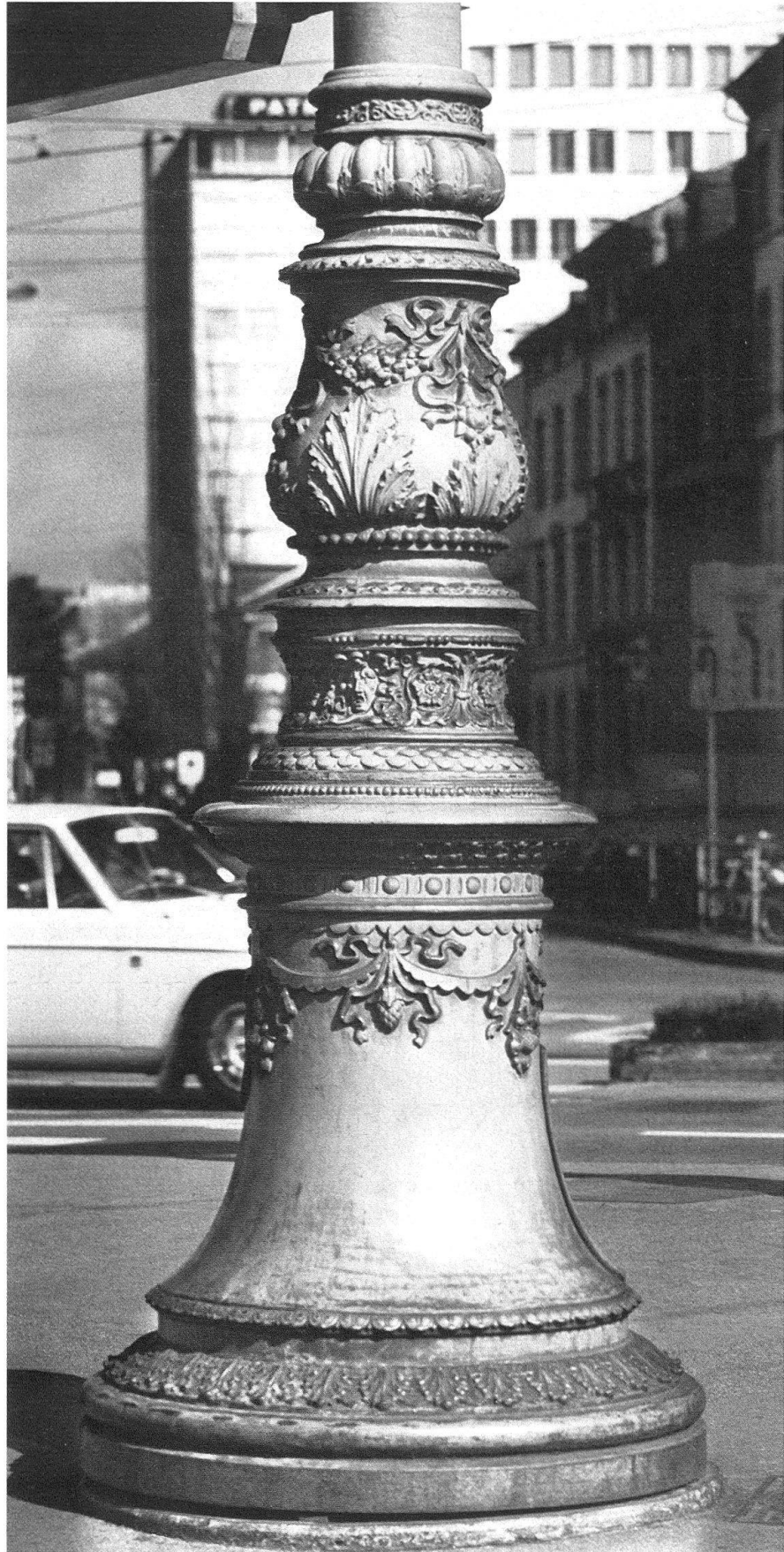
Leitungsmast am Aeschenplatz, aufgestellt vermutlich beim Bau der Birsfelder Linie im Jahre 1897. Gusseisenverklei- dung aus dem Eisenwerk Klus bei Balsthal, dieselbe wie an den Masten der 1895 eröffneten ersten elektrischen Tramlinie der Stadt
