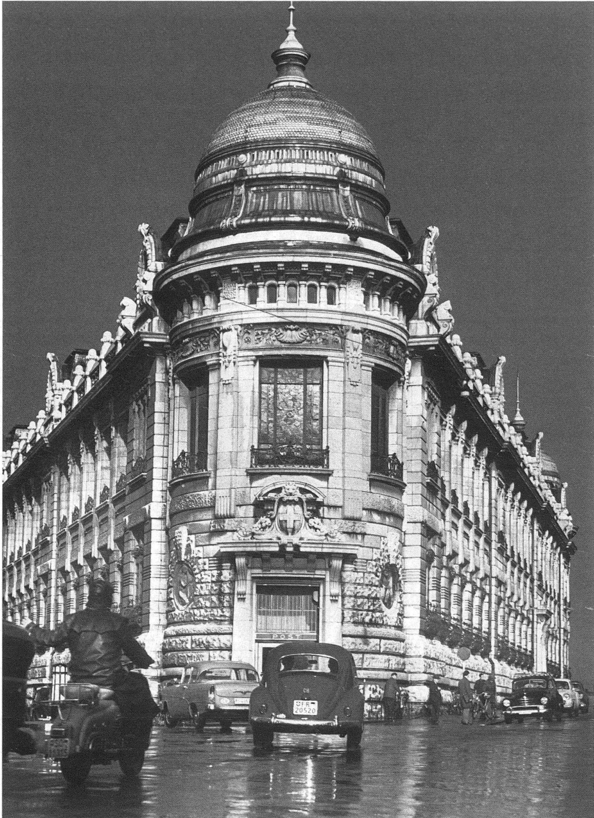
Post Basel 2 (Bahnhofpost), Centralbahnstrasse/Eilgutstrasse/Peter-Merian-Strasse, 1905–1907 von der Direktion der Eidgenössischen Bauten, deren Chefarchitekt damals Theodor Gohl (1844–1910) war, gebaut. Zwei überkuppelte zylindrische Baukörper rahmten die bahnwärts gerichtete Hauptfront, aber nur der eine erfüllte die seit 1800 übliche Aufgabe: am spitzen Winkel des Baublocks Gelenk zu sein. 1976 abgerissen
