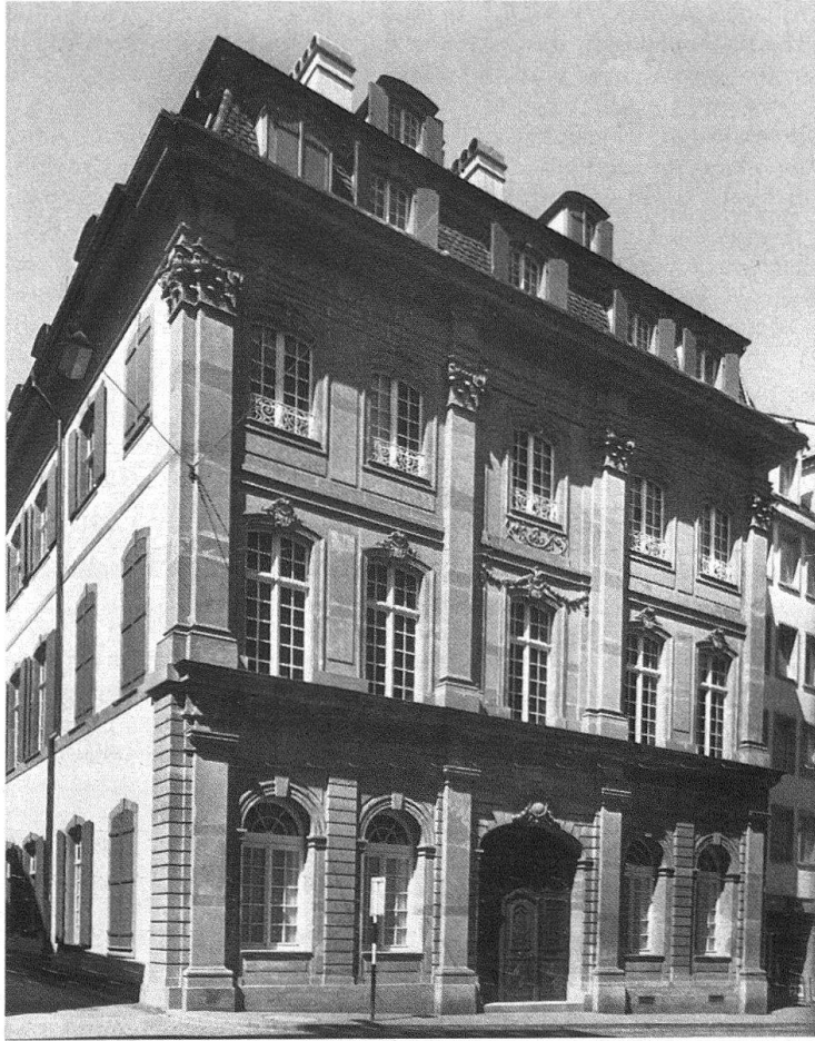
Stadthaus, ehemals Posthaus, Stadthausgasse 13, 1771–1775 von Samuel Werenfels (1720–1800). Der Sitz des Direktoriums der Kaufmannschaft sieht wie das Wohnhaus eines reichen Kaufmanns aus und ist auch ähnlich eingeteilt: Wagentur durchfahrt zum Hof für die Postkutschen, Geschäftsräume und Treppenaufgang im Erdgeschoss. Repräsentationsräume im ersten Stock und im zweiten Stock die Wohnräume des Postverwalters
