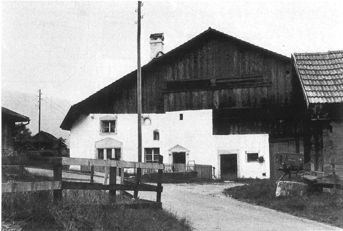
Fig. 3. Grandval, la maison dite «L'ancienne Cure», après sa restauration (n° 2 du plan fig. 2). A droite, le grenier de la ferme. A gauche, l'angle de la maison dite «Du banneret Wisard»
