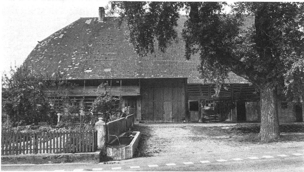
Abb. 5. Grafenried, Bauernhaus Iseli-Lüdi. Schöner strassenseitiger Hausplatz, mit Grien belegt, die Partie vor dem Stall gepflästert; Jurasteinbrunnen, gezöpfler Mist unter Laubbaum; vor dem Wohnhaus der Garten
