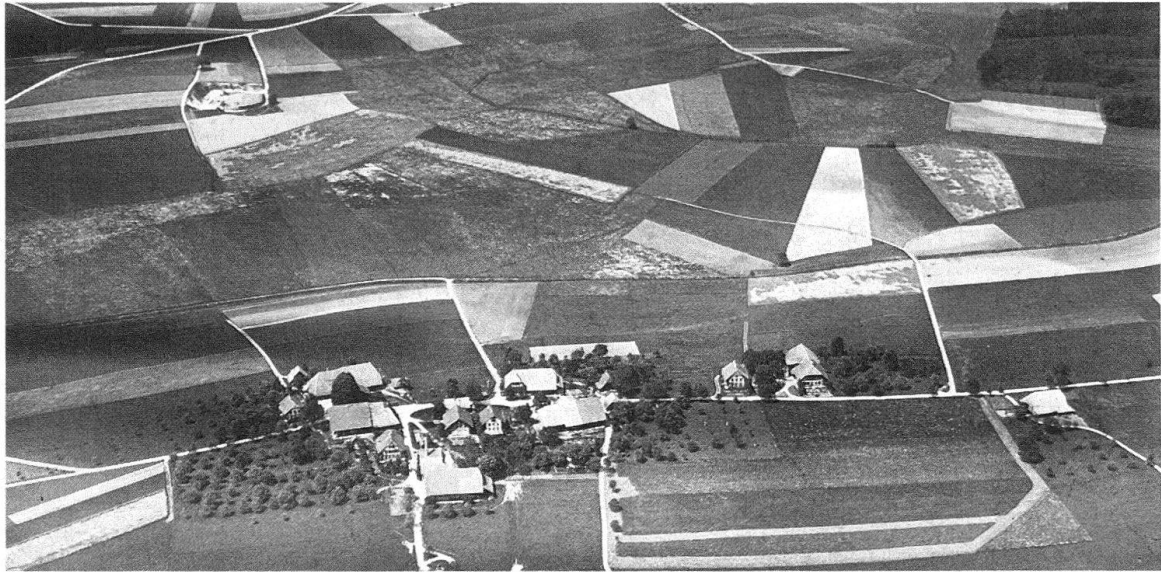
Abb. 1. Ballmoos, Vogelperspektive. Von den beherrschenden Volumen der Bauernhäuser sind die kleineren Stöckli, Speicher und Schöpfe deutlich unterschieden; Gärten, Wege und von Bäumen beschattete Hausplätze zwischen den Häusern; Obstbaumgärten leiten vom Dorf zum freien Feld über
