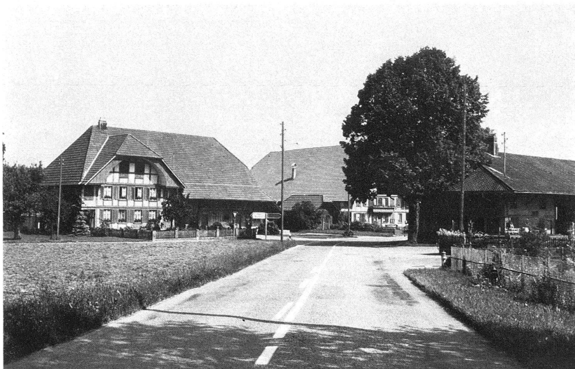
Abb. 3. Grafenried. Markanter südlicher Dorfeingang mit stattlichen Bauernhäusern und prächtiger Linde in der Wegbiegung. Intakte Höfe mit Kleinbauten und gepflegten Gärten
