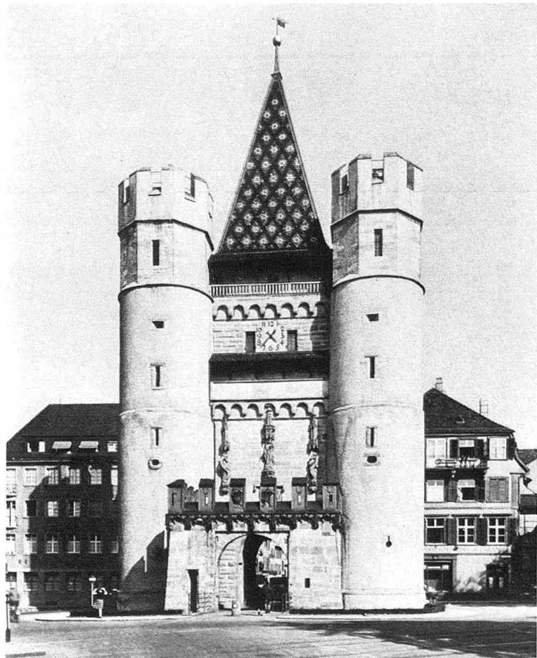
Basel. Das Spalentor, Ansicht von Westen
