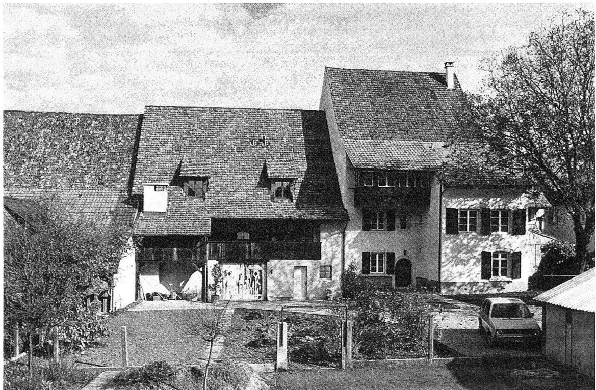
Itingen. Blick auf die noch nicht ganz vollendete Rückseite, auf der sich der Scheunenteil – mit der Laube und dem Tor als Wohnteil umgestaltet – dennoch rustikal ausnimmt. Die prekären Lichtverhältnisse verlangten den Einbau von zwei schmalen Dachaufbauten
