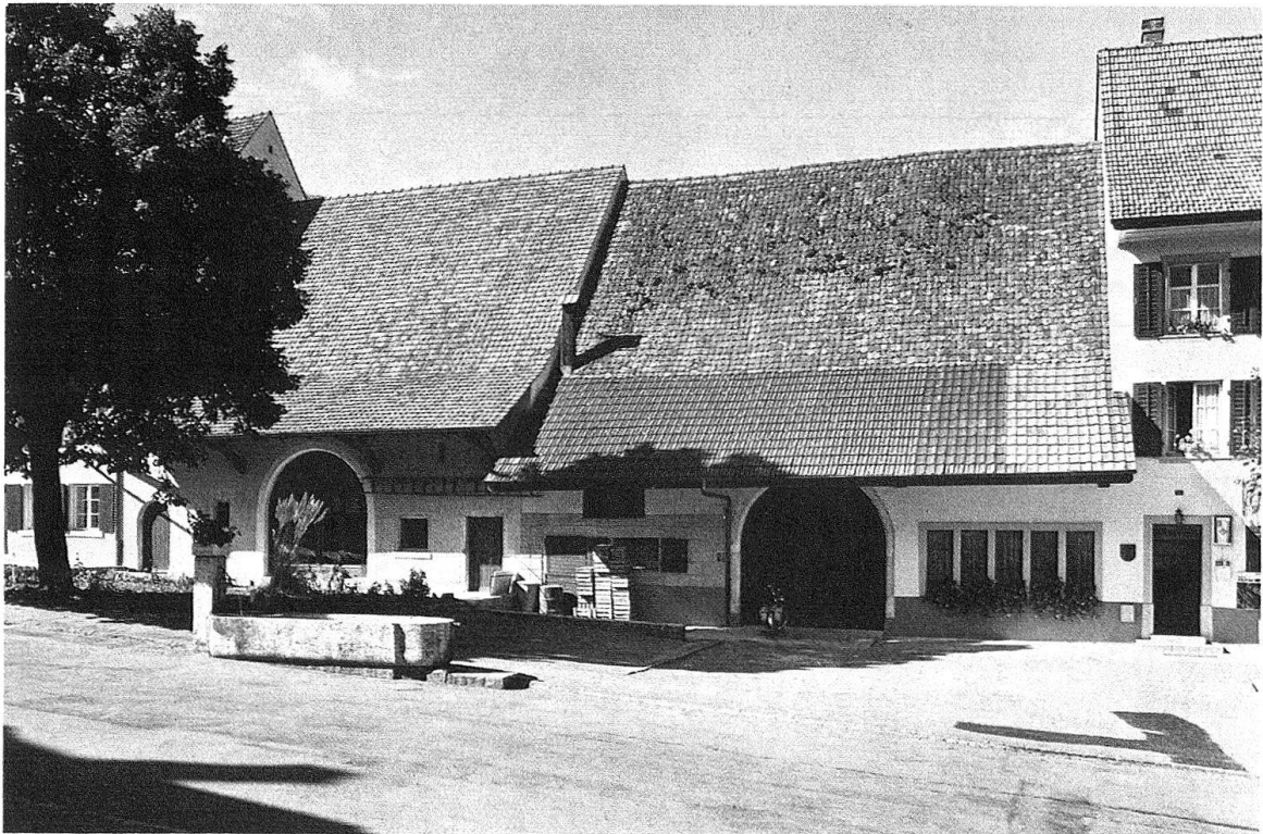
Itingen. Blick auf die restaurierte Scheune Nr. 35. Die anschließende Scheune Nr. 37 wurde zusammen mit dem dazugehörigen Wirtshaus ebenfalls renoviert, wobei an der Stelle des Stalles ein kleiner Saal eingebaut worden ist
