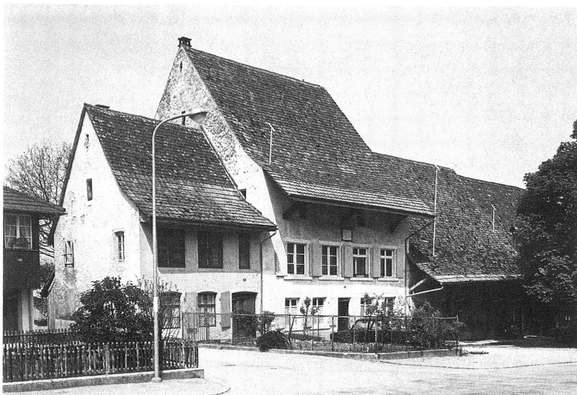
Itingen BL. Die Häuser Nr. 33 und Nr. 35 vor der Restaurierung mit den Profilen des geplanten Neubaus auf den Dächern. Der untere Teil des Scheunendaches droht zusammenzubrechen. Mit dem Neubau wäre die Lücke zwischen Nr. 31 und 33 durch die Verbreiterung der Seitenstrasse grösser geworden
