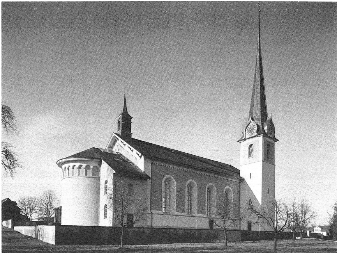
Ballwil, Pfarrkirche St. Margrethen. Äusseres von Nordosten nach der Restaurierung, 1977
