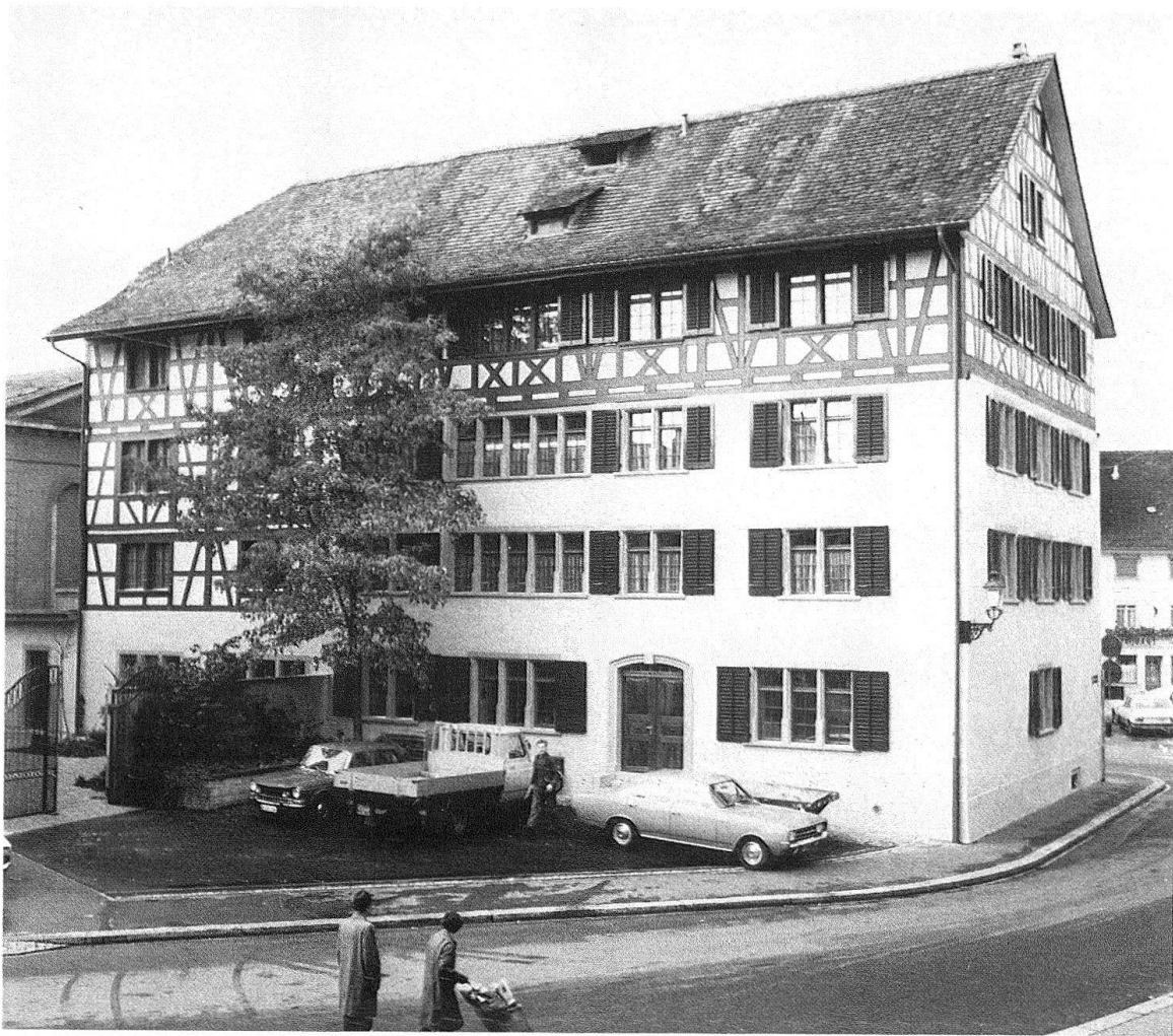
Winterthur. «Königshof», Neumarkt 4. Restauriert 1975/76 durch das Hochbauamt Winterthur
