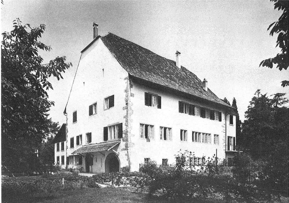
Stäfa. Üerikon. Ritterhäuser. Burgstall. Nach der Aussenrestaurierung
