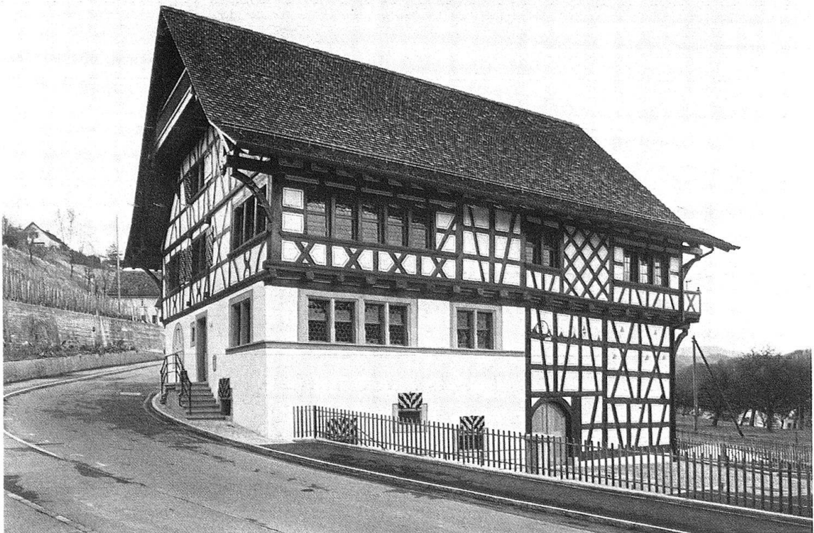
Eglisau. Das 1682 erbaute Weinbauernhaus am Weierbach, nach der Gesamtrestaurierung
