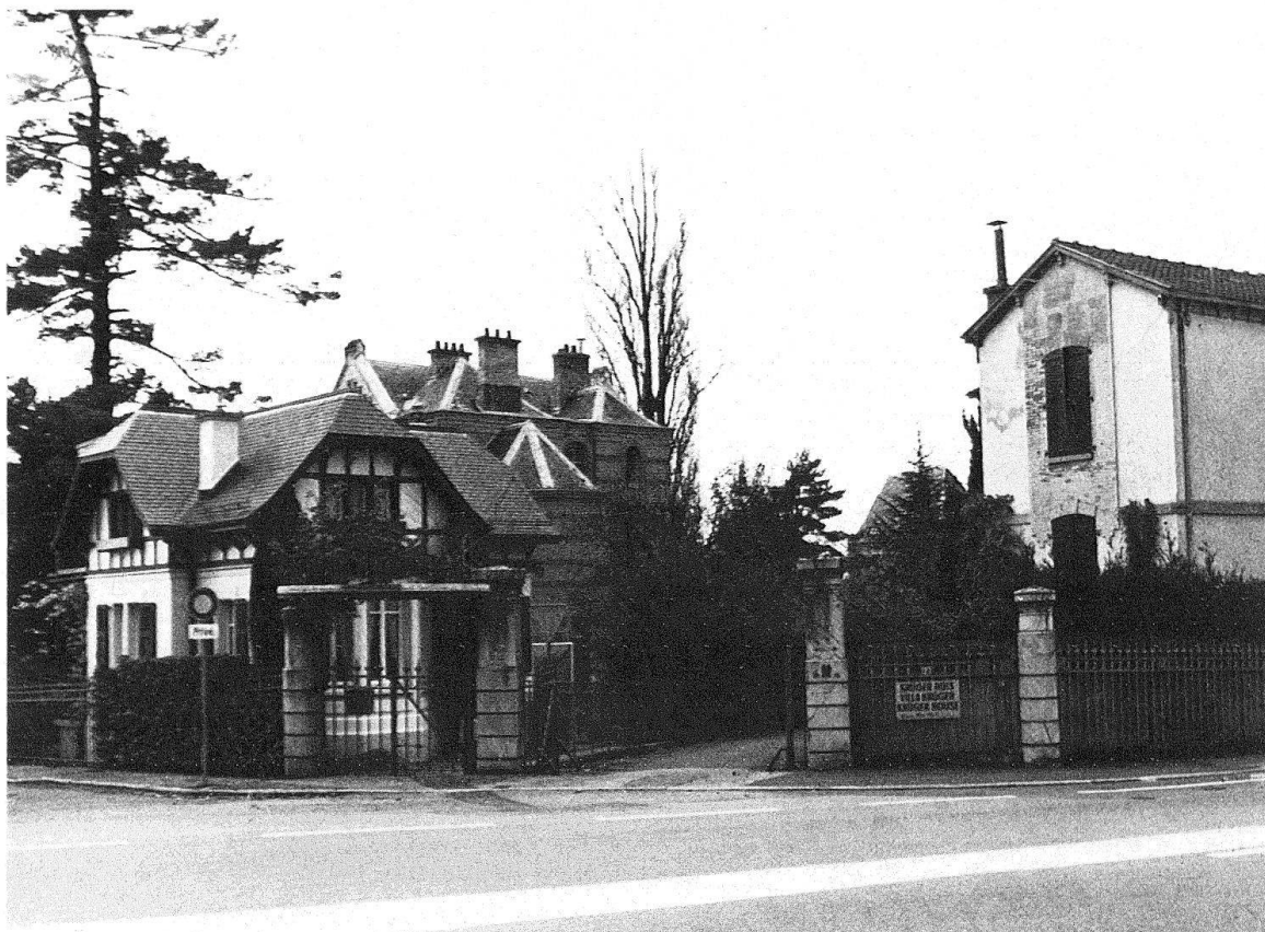
Fig. 8. Cité de villas, 1874–1880, entrée principale au levant, flanquée des pavillons du concierge et du régisseur
