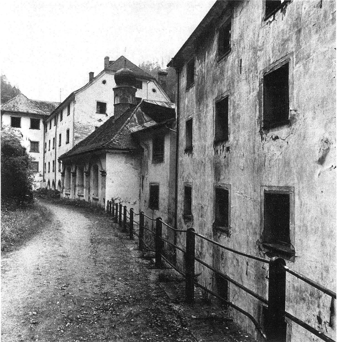
Bad Pfäfers. Im Vordergrund das 1974 abgebrochene sog. kleine Haus mit den ehemaligen Badanlagen, dazwischen die Kapelle, hinten das 1829 aufgestockte Gasthaus mit dem barocken Querbau
