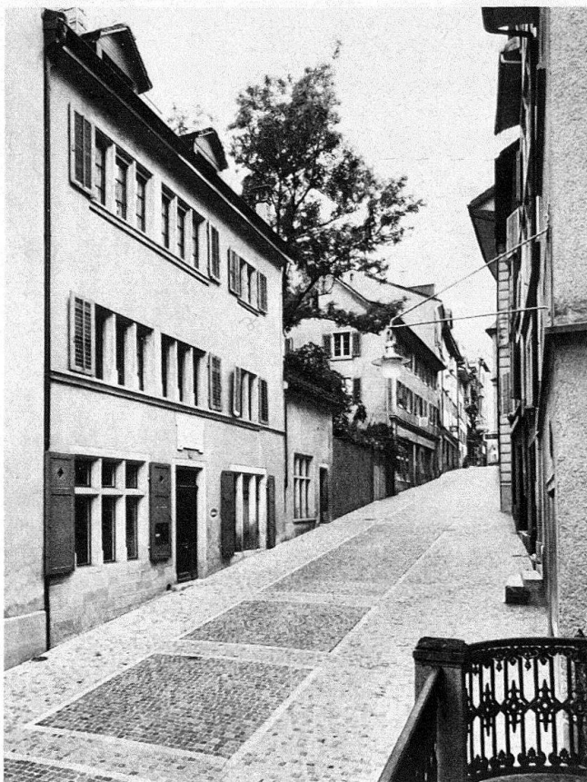
Zürich. Kirchgasse. Die neue Kleinplästerung, ohne Trottoirs – ausgeführt nach Plänen der städtischen Denkmalpflege: ein wohnlicher Bereich, ideal für den Fussgänger
