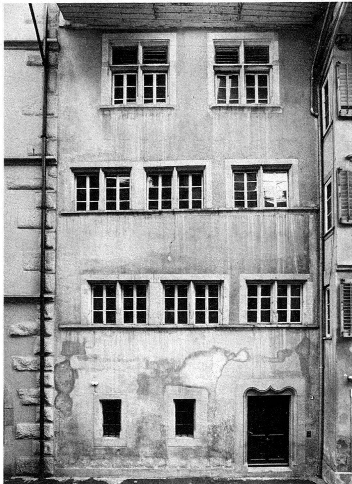
Zug, Ulmihaus, Haus 3, Unteraltstadt. Die Westfassade vor der Restaurierung (April 1977)
