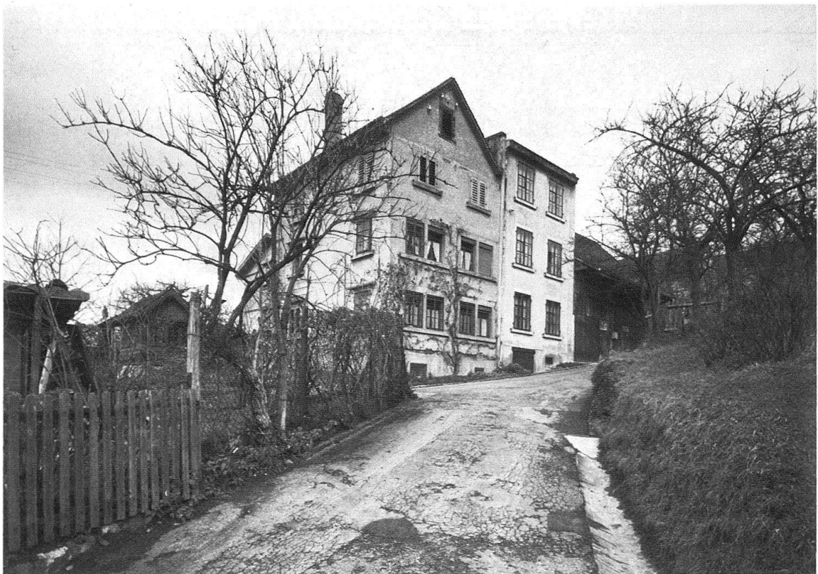
Abb. 2. Zürich-Hirslanden. Burenweg 35/37. Heutiger Zustand. Ein dreistöckiges Haus ersetzt den Wohnteil des Altbaues, die Schiebläden mussten Rolläden weichen
