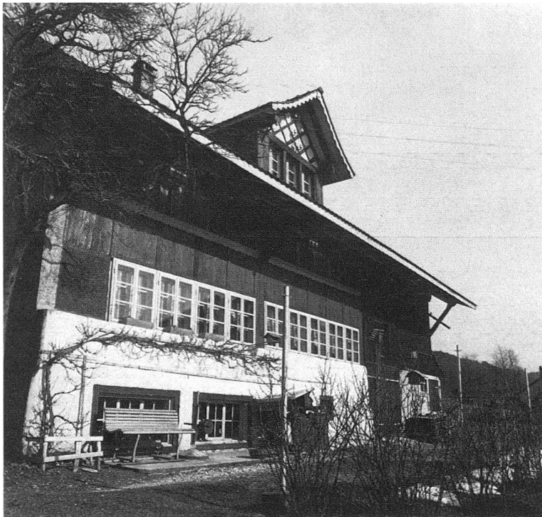
Bauma. Vorder Tiefenbach. Heimarbeiter- und Kleinbauernhaus von 1785. Webkeller im Untergeschoss des linken Haus-teils, Stallanbau an die rechts liegende Wohnung angefügt
