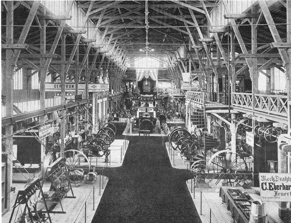
Gewerbeausstellung Zürich 1894. Inneres der Maschinenhalle (Stadtarchiv Zürich)
