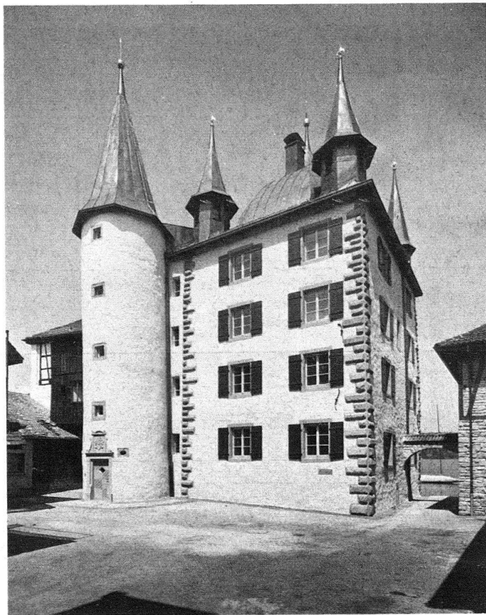
Steckborn. Turmhof nach der Restaurierung
