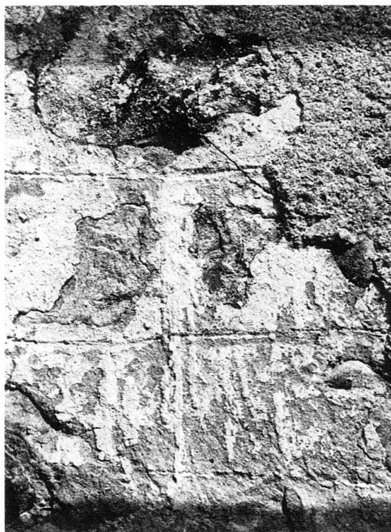
Weiningen. Kapelle. Mauerwerk mit romanischem Fugenstrich und vereinheitlichender Kalkschlemme
