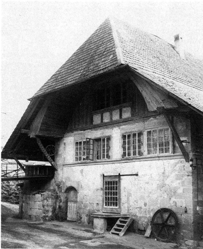
Radelfingen, Landerswil. Dreigeschossiger Speicher von 1680. Auch die Speicher gehören, obschon meist nicht ohne gefällige Wirkung, zu den durch Funktionsverlust gefährdeten bäuerlichen Kleinbauten. Dieses seltene dreigeschossige Beispiel konnte erst nach langen Verhandlungen in Zusammenarbeit mit dem Berner Heimatschutz wiederhergestellt werden. Der spätere Schindelschirm wurde dabei ebenfalls erneuert. Oben: vor, unten: nach der Restaurierung
