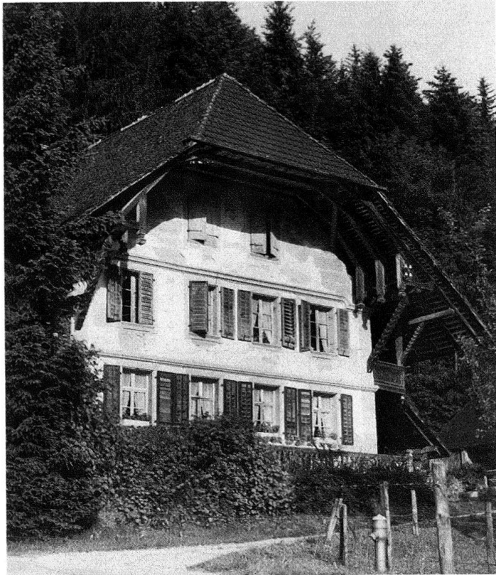
Seeberg, Riedwil. Wohnstock des ehemaligen Mühlehofes von 1811. Wohl einer der repräsentativsten Zeugen ländlicher Wohnkultur im bernischen Mittelland. Die vollständig in Sandstein ausgeführte Fassade bot Erhaltungsschwierigkeiten bautechnischer Art, welche im Normalfall die finanziellen Möglichkeiten der Besitzer übersteigen. Aufwendige Sandsteindekorationen sind aber für das bernische «Stöckli» charakteristisch. S. 70 vor, S. 71 nach der Restaurierung
