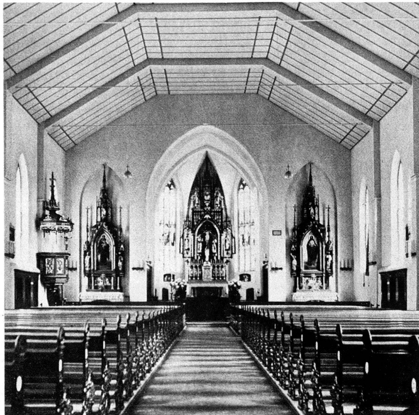
Zürich. Kath. Kirche St. Peter und Paul, 1893/94. Aussicht gegen den Chor vor (rechts) und nach (unten) der Restaurierung 1980
