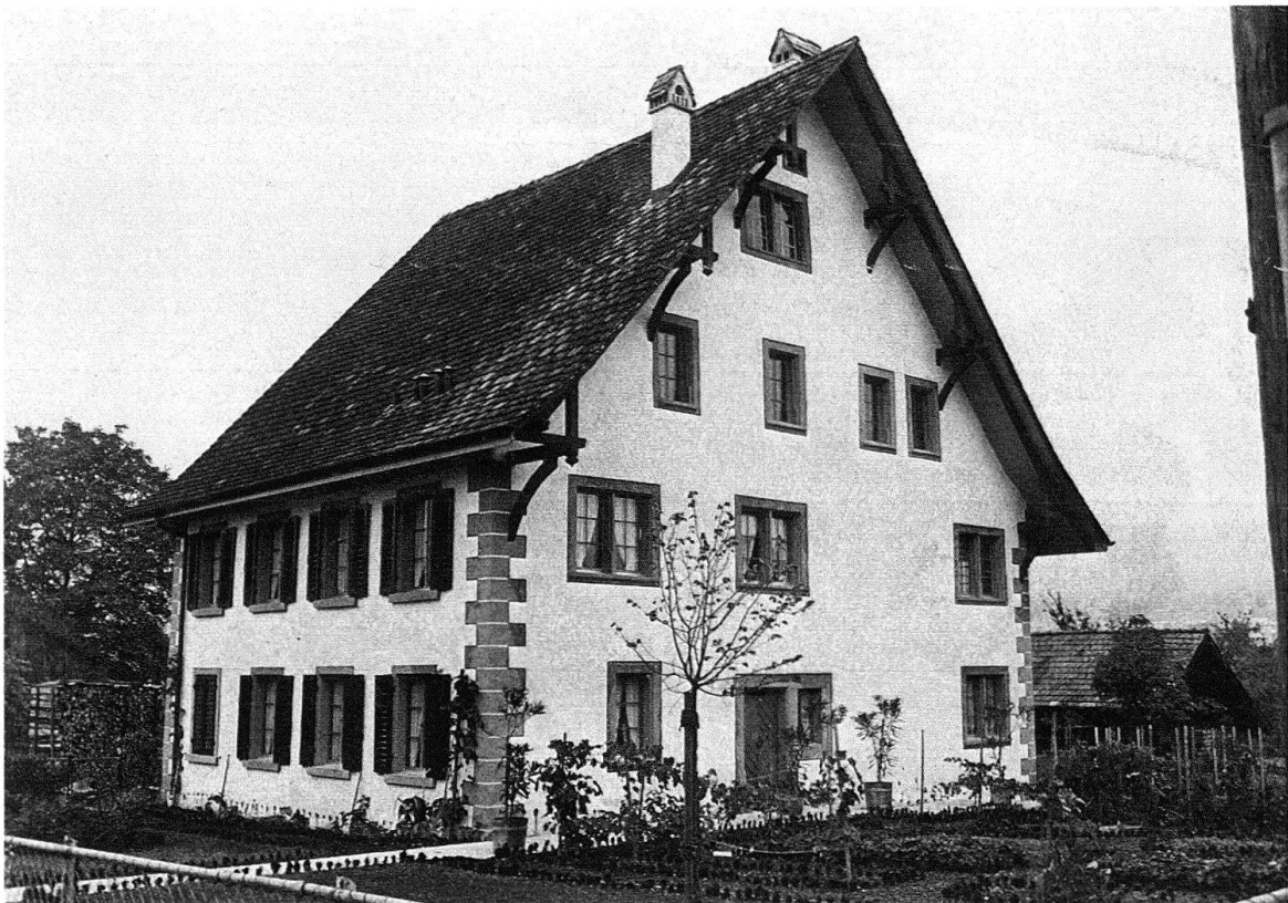
Urdorf, Birmensdorferstrasse 149. Ehem. Heilbad des 18. Jh. Nach der Restaurierung 1977–1980
