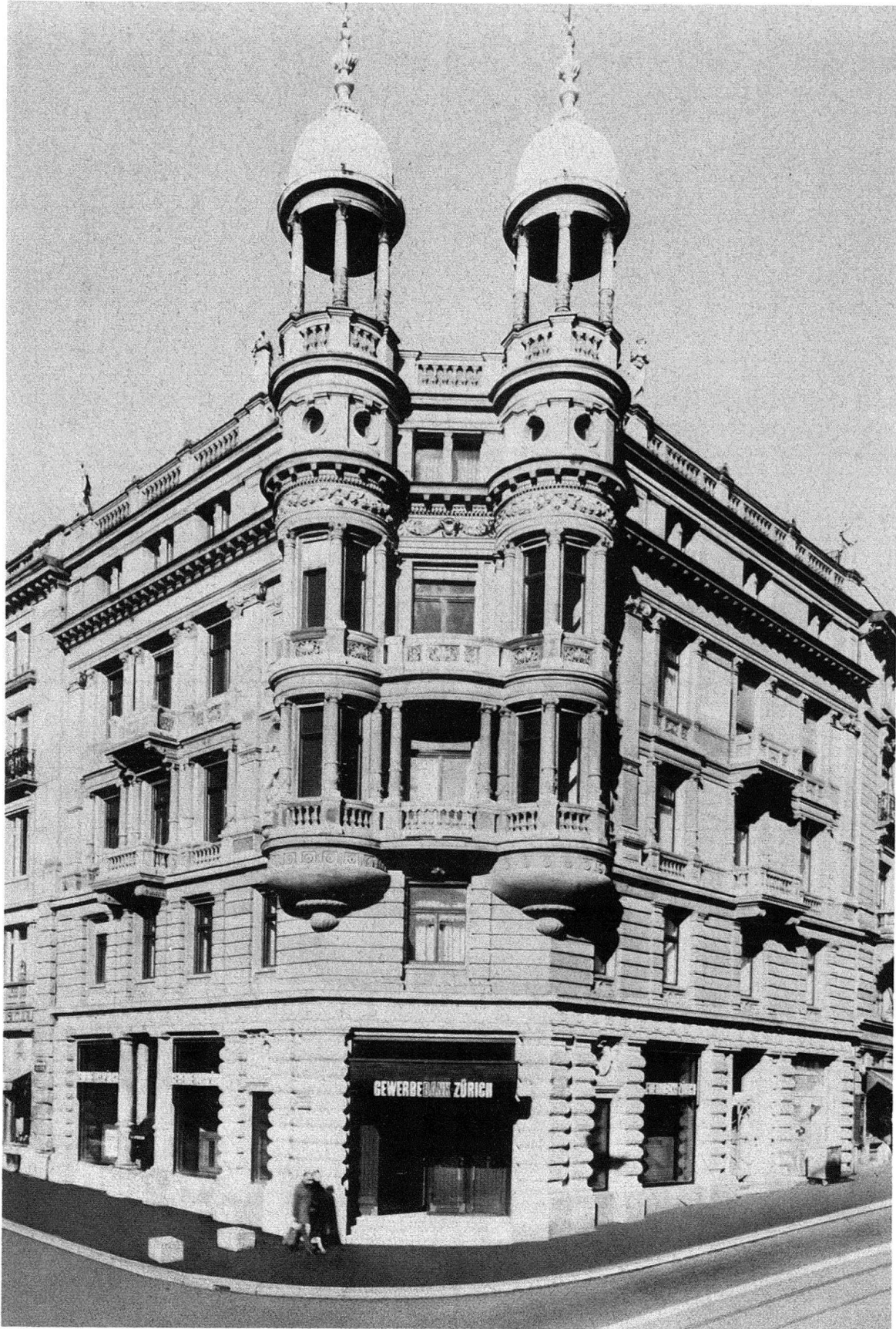
Zürich. Rämistrasse 23, «Gewerbebank». Fassade nach der Renovation
