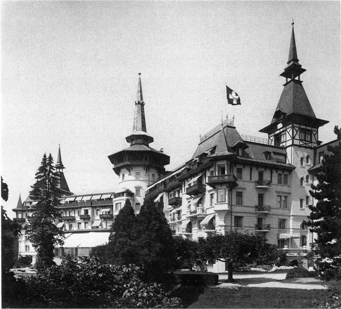
Zürich. Kurhausstrasse 45, «Grand Hotel Dolder». Die renovierten und teilweise ergänzten Fassaden und Dachflächen
