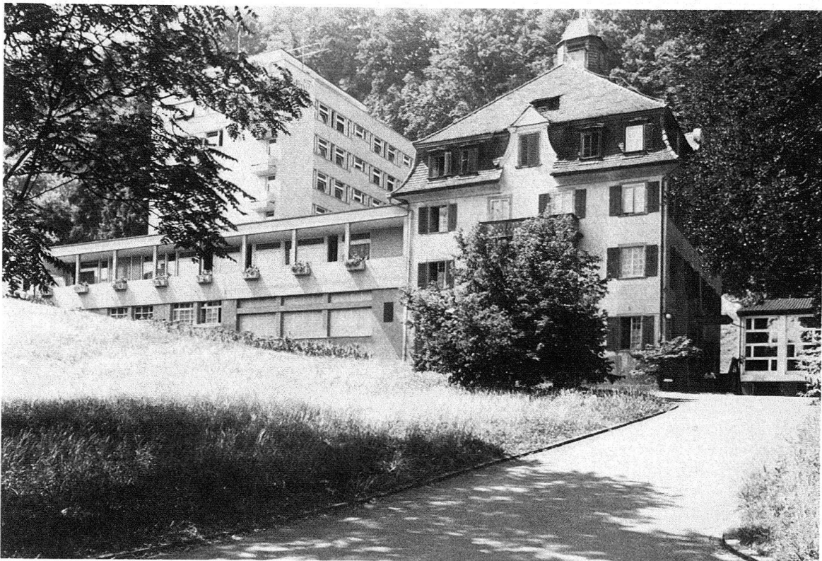
und heute – ein Kommentar erübrigt sich. Der alte Hauptbau rechts im Bilde wurde kürzlich denkmalpflegekonform restauriert
