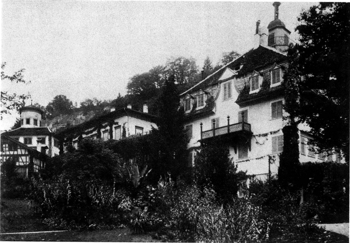
Ehemalige «Weinburg» in Thal vor dem Umbau
