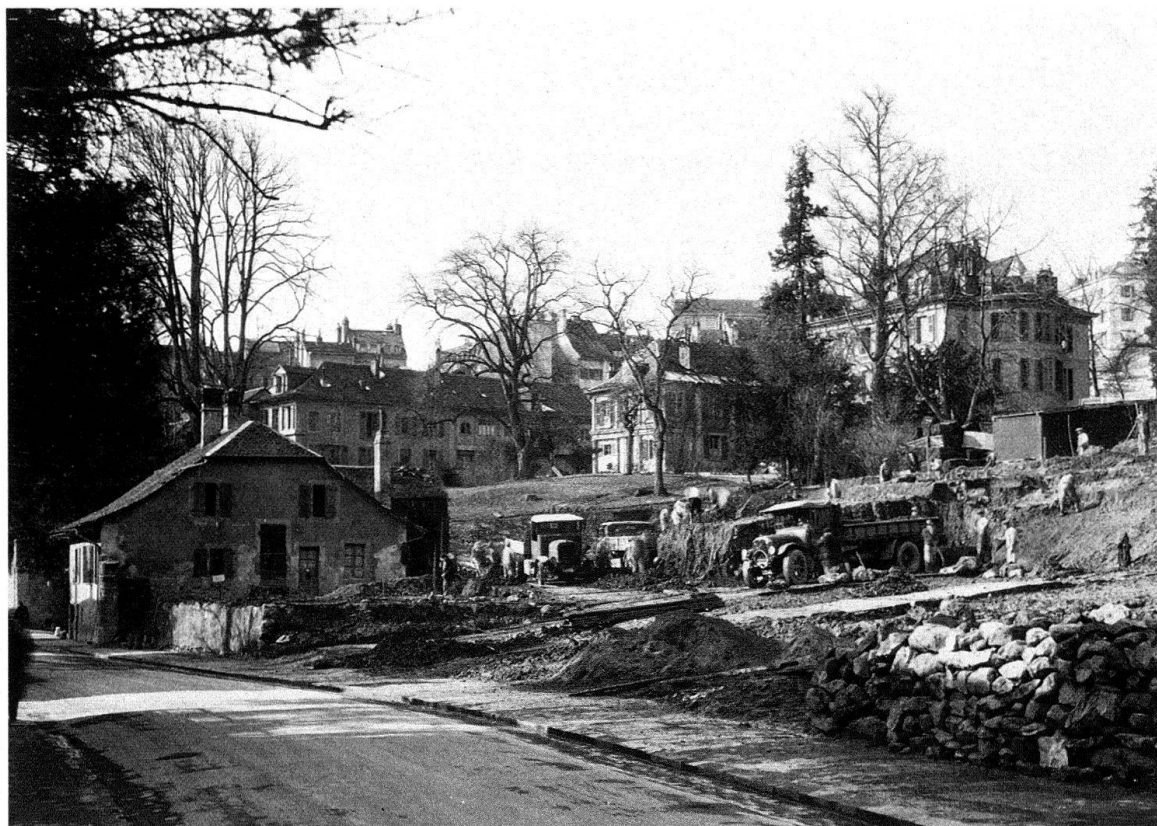
Villamont et la maison Maisonny, lors des travaux pour la création de l'avenue Mon-Repos en 1935
