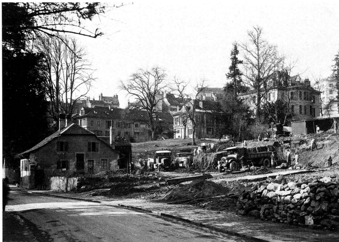
Villamont et la maison Maisonny, lors des travaux pour la création de l'avenue Mon-Repos en 1935
