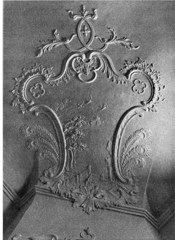
Eckkartusche im Deckenstück des Treppenhauses mit dem Symbol des Elementes Luft; nach der Restaurierung
