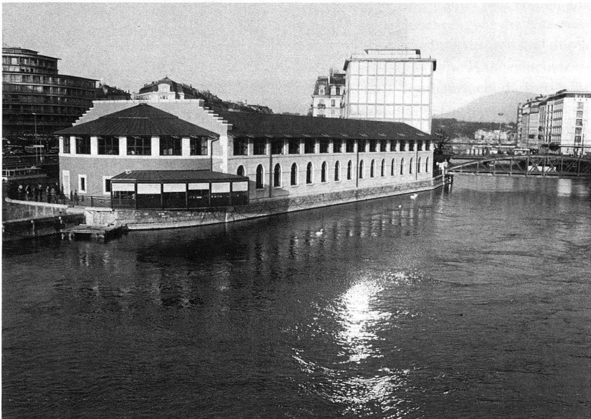
Genève, Halles de l'Île; vue de l'extérieur après la rénovation de 1979–1981
