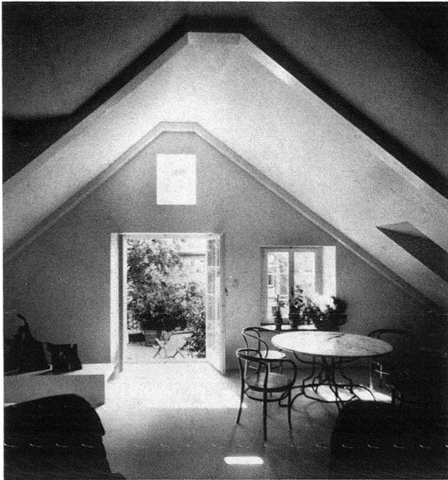
Abb. 15. Wohnzimmer der Dachwohnung mit Blick gegen die Giebelwand, erkennbar die Hetzerbalken. Im Hintergrund die kleine Dachterrasse
