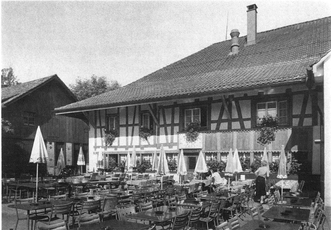
Abb. 8. Tobelhof. Aktueller Zustand der Restaurantseite. Die alte Bausubstanz ist zwar noch einigermaßen erhalten, die Erneuerungen sind aber mit wenig Sinn für das wichtige Detail ausgeführt. Man vergleiche etwa die neuen Vordachstützen mit den originalen auf der Rückseite des Hauses (Abb. 7)
