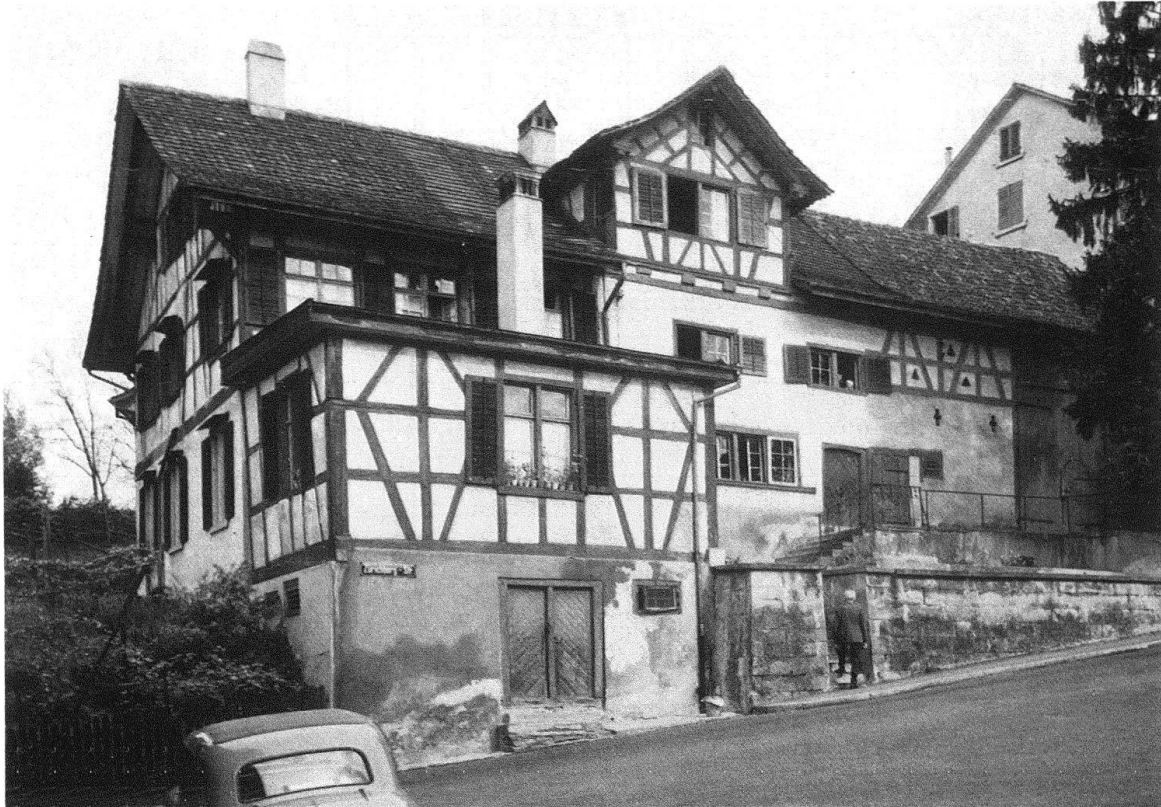
Abb. 9. Fluntern. Zürichbergstrasse 59. Die reizvolle Gebäudegruppe mit Bauteilen aus dem 16.–19. Jahrhundert wird gegenwärtig renoviert. Der Scheunenteil muss leider umgestaltet werden. Man beachte die Bedeckung mit Hohlziegeln
