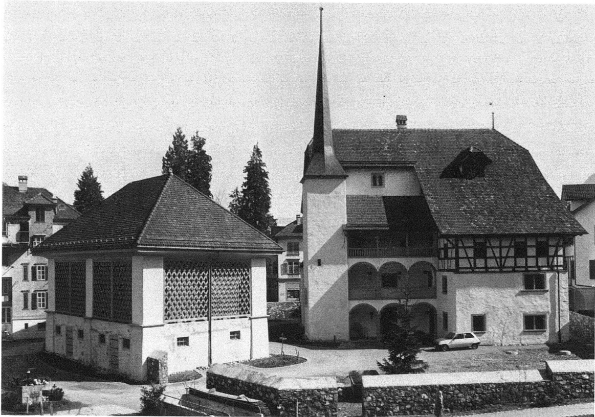
Abb. 12. Westfassade nach der Restaurierung
