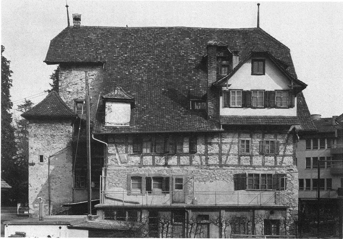
Abb. 11. Stans. Höfli, Westfassade vor der Restaurierung
