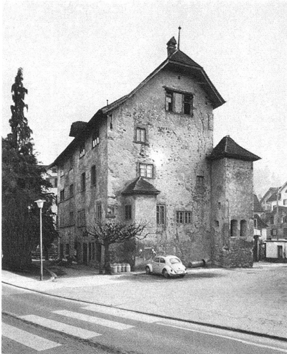
Abb. 1. Nordfassade vor der Restaurierung
