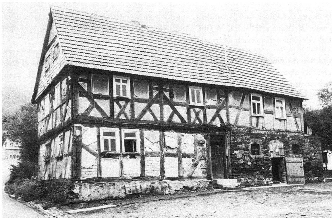
Bellnhausen, Lanzenbacherstrasse 33. Ländlicher Fachwerkbau vom Anfang des 18. Jh. mit 3 Zonen (von l. nach r.): Stube, Ern (= Flurteil) und Stall, massiv erneuert. Ursprünglich war das Haus nur zweizonig, was an der Dachnaht noch sichtbar ist
