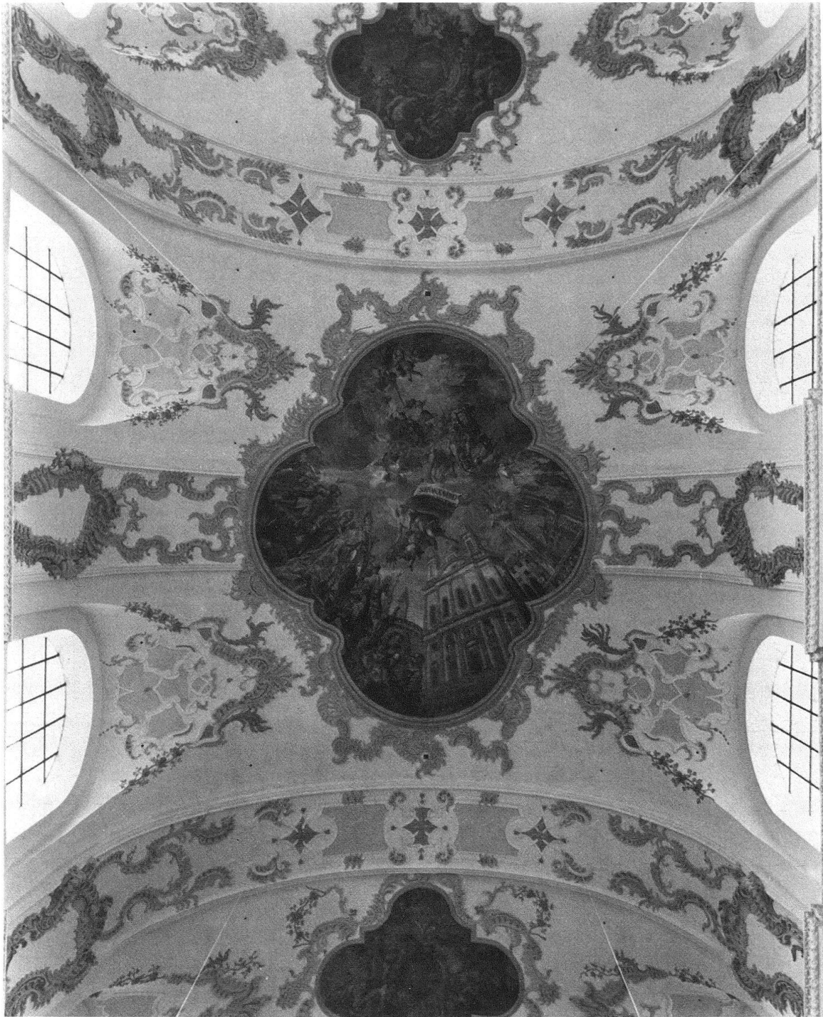
Abb. 3. Luzern, Jesuitenkirche. Gewölbe mit Stukkaturen von 1749 und mit Deckengemälden der Brüder Torricelli
