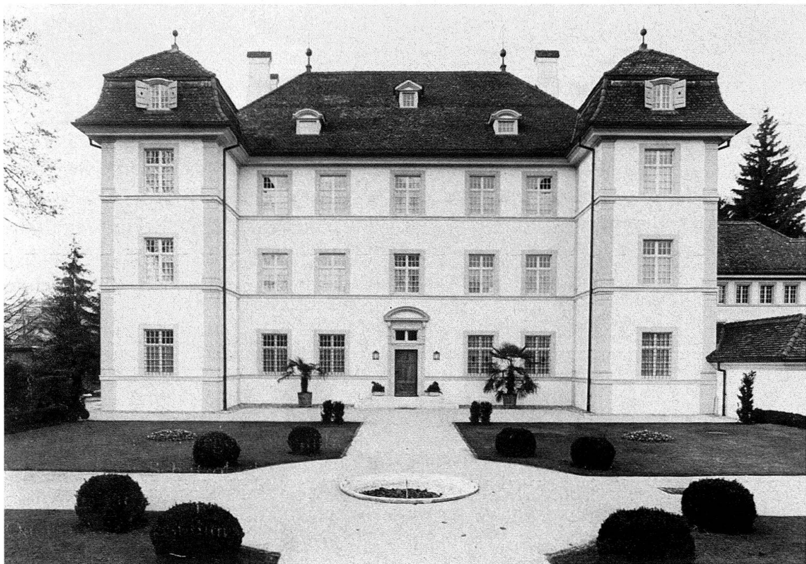
Abb. 1 und 2. Die Hauptfassade vor und nach der Restaurierung. Der in Mörtel vorgeklebte «Mittelrisalit» des 19. Jahrhunderts wurde entfernt. Die Ecken der Türme erhielten eine einfache Bemalung in barocker Manier. Der Archivtrakt rechts aussen wurde auf seine ursprüngliche Höhe abgestockt
