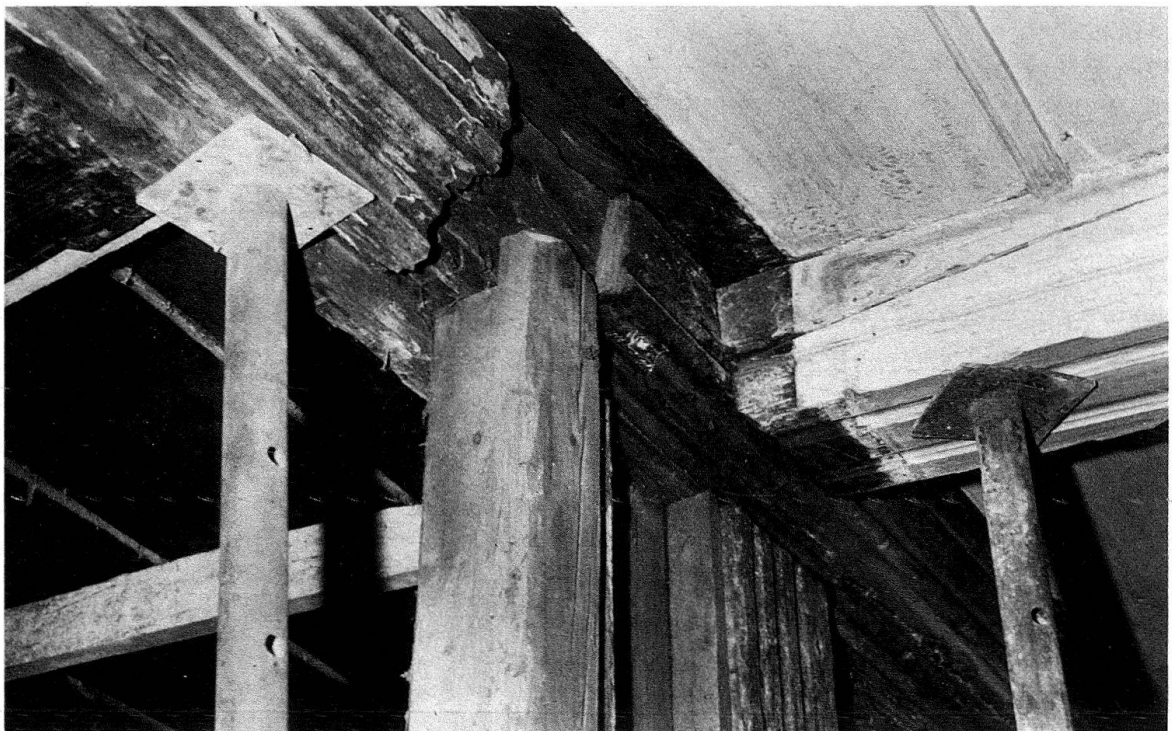
Abb. 5-6. Twann, Haus Nr. 136, erstes Obergeschoss, Hauptstube, Aufdeckungen 1981
