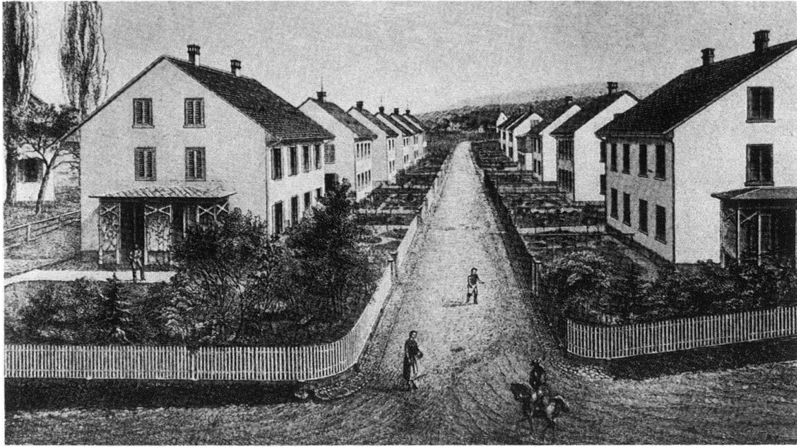
Abb. 5. Arbeitersiedlung der Maschinenfabrik Rieter in Töss ZH, 1866–1870. Lithographie von Wurster, Randegger u. Co., Winterthur
