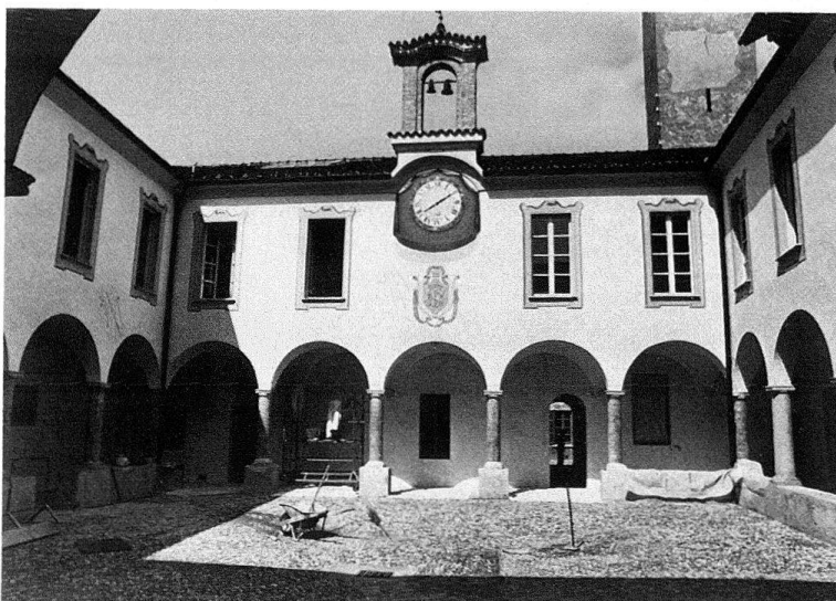
Fig. 4. Mendrisio, antico convento dei Serviti, il chiostro nell'ultima fase dei restauri
