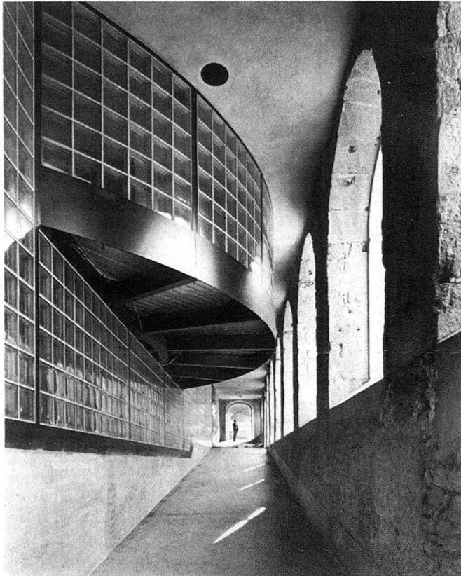
Abb. 7. Aussenansicht der Glasziegelwand mit überhängender Apsis
