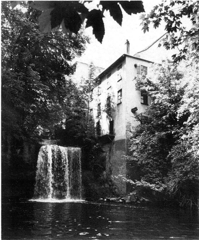
Abb. 3. Bubikon, Fabrikanlage «Im Schwarz», Bestand 1981 vom Bach her (Rückseite), im Vordergrund ehem. Wasserhaus
