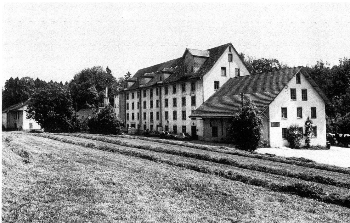
Abb. 2. Bubikon, Fabrikanlage «Im Schwarz», Bestand 1981 (vor Brand)
