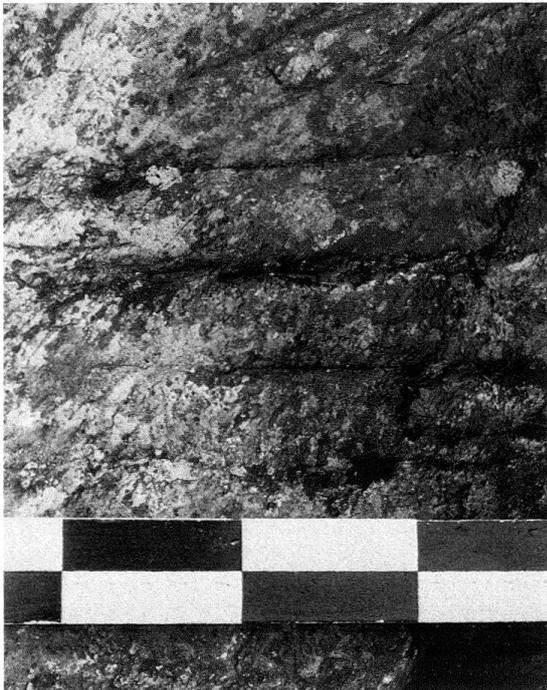
Abb. 1. Ober Gurtnehen UR. Umgehungsweg der Reuss-Schluchten zwischen Wiler und Amsteg. Die Trittrillen, die das Ausgleiten von Fuss und Huf verhindern sollen, sind von der Begehung während Jahrhunderten fast wieder ausgelöscht (Koord. 691 37/17824. Massstab mit 10-cm-Teilung)
